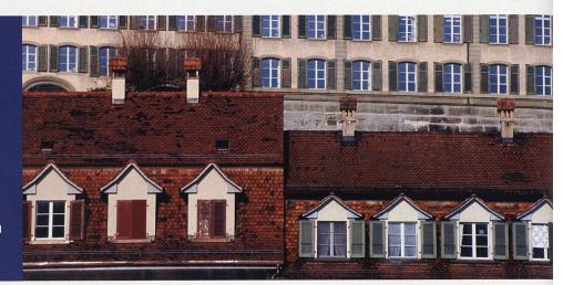
Können alte Fenster nicht erhalten werden, sollten sie möglichst originalgetreu ersetzt werden. Kunststoff und aufgeklebte «Schwindelsprossen» sind bei historisch wertvollen Bauwerken fehl am Platz.
