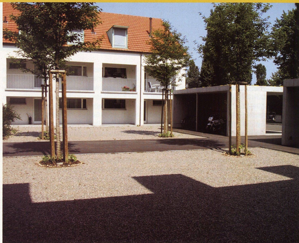
Die Seniorenwohngenossenschaft Pestalozzi in Muttenz BL musste Parkplätze bauen, die sie nicht braucht. Nun stehen die bekiesteten Flächen im Innenhof leer, wertvoller Grünraum geht verloren.
