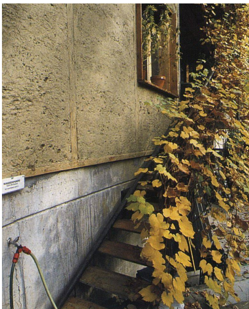
Detailansicht einer unverputzten Lehmwand.
