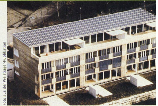
Zu den Solarpreisträgern 2002 gehört das Sechsfamilienhaus «Sunny Woods» in Zürich-Höngg. Mit dem Fotovoltaikdach erzeugt der Null-Heizenergie-Bau den Strom für die Wärmepumpe selbst. In die Brüstungselemente vor den raumhohen Fenstern sind zudem Vakuum-Röhrenkollektoren eingebaut.
