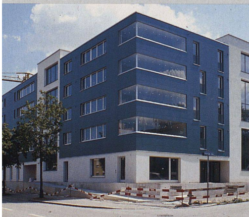
Der Langbau von der Strassenseite; im Parterre sind ein Verein, eine Krippe und Ateliers untergebracht.
