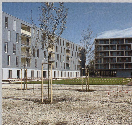
Die beiden Bauten vom Hof aus, wo soeben die Bäume gepflanzt wurden.
