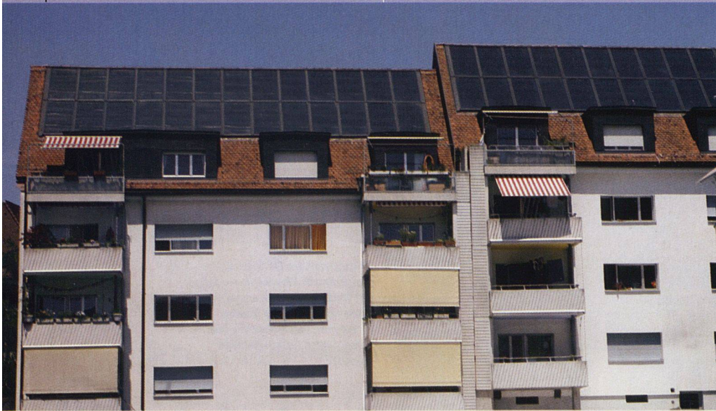
22 Tonnen Erdöl jährlich spart die Baugenossenschaft Freiblick mit den neuen Kollektoren auf den Dächern zweier Wohnblöcke am Zürcher Milchbuck.
