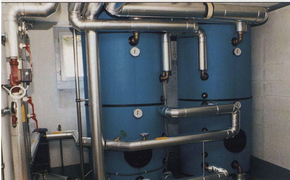
Speicheranlage für das solar vorgewärmte Wasser im Keller der Siedlung Herzogenmühle. Rund ein Viertel der Kosten konnte mit Fördergeldern der Aktion «Züri Solar» gedeckt werden.
