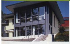
Das auf der bekannten Kronenberger CMS Linie basierende Kunststoff-Fenster ist aussen mit Aluminium verkleidet und in jeder gewünschten Farbe erhältlich. Hervorragende Wärme- und Schalldämmung, eine robuste Profilkonstruktion, hohe Sicherheitsstandards und überdurchschnittliche
