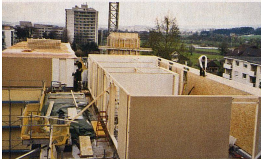
Aufbau der Attikawohnungen auf dem bestehenden Gebäude.
