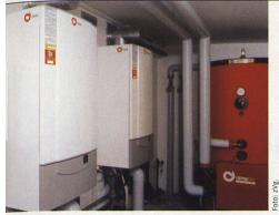
Dachzentrale mit zwei modulierenden 40-kW-Kondensations-Wandkesseln für fünf Wohnungen, Büros und Läden in einem sanierten Altbau in Vevey.
