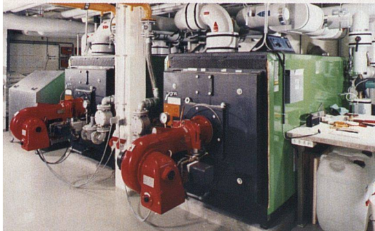
Kondensierende Fernheizzentrale in Steinhausen: Zwei 600-kW-Kessel mit Gas-Gebläsebrenner, hinten ein 400 kW-Ölkessel.
