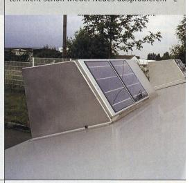
Die Elektronik wird mit Solarzellen betrieben, die auf der Rückseite der Schleusenaufsätze angebracht sind.
