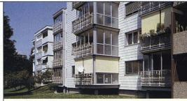
Nach einer umfassenden Sanierung erfüllt der Wohnbau in Embrach die Anforderungen von Minergie nicht zuletzt wegen einer guten Wärmedämmerung und der dichten Gebäudehülle aus Faserzement «Eternit».
