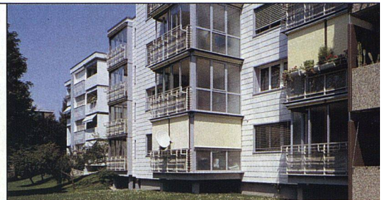
Nach einer umfassenden Sanierung erfüllt der Wohnbau in Embrach die Anforderungen von Minergie nicht zuletzt wegen einer guten Wärmedämmung und der dichten Gebäudehülle aus Faserzement «Eternit».
