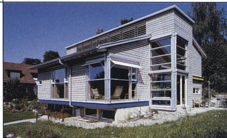
Dieses modern anmutende Wohnhaus in Bülach trägt das Minergie-Label. Es ist mit Faserzement «Eternit» in Stülpedeckung bekleidet.
