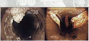
Kalkablagerung und Wurzeleinwuchs sind Schäden, die in Hausentwässerungsleitungen auftreten können.
