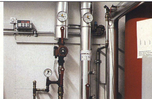
Über einen Wärmetauscher liefern die Sonnenkollektoren vorgewärmtes Wasser in die Boiler.
