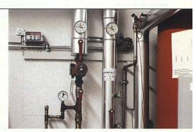
Über einen Wärmeaustauscher liefern die Sonnenkollektoren vorgewärmtes Wasser in die Boiler.
