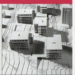
Grösstenteils aus Holz sind die vierstöckigen Wohnbauten, die die FGZ am Hegianwandweg in Zürich Friesenberg baut. Sie erfüllen den Minergie-Standard.
