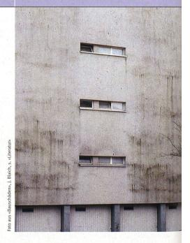
Algen- und Schimmelbildung sind die Kehrseite einer guten Aussenwärmedämmung. Mit solchen Schäden muss bei Neu- oder Umbauten, an verputzten wie hinterlüfteten Fassaden gerechnet werden. Abhilfe bietet die – ökologisch allerdings unbefriedigende – Zugabe von Algengiften in die Putzmasse.
