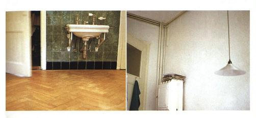
Heizungs- und Wasserrohre sind für die Übertragung von Luftschall verantwortlich. Bei den Sanitärinstallationen werden heute schallgedämmte Übergänge bei den Deckendurchdringungen eingebaut. Probleme kann jedoch die Sanierung der Heizungsverteilung bereiten.
