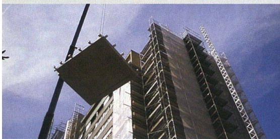
Montage einer Betonplatte für den Veranda-Anbau.
