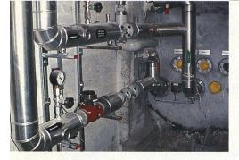
Die Installationen im Haus sind bei der Fernwärme sehr Platz sparend. Heizkessel, Brenner und Tankraum sind nicht notwendig.
