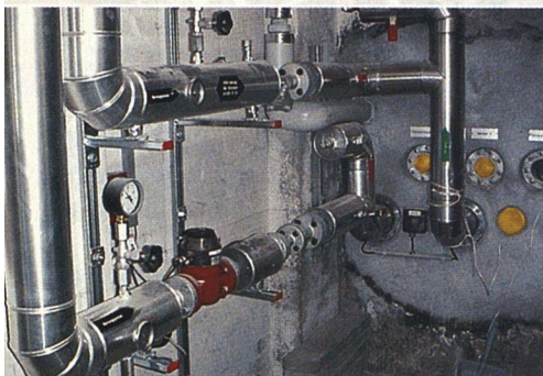
Die Installationen im Haus sind bei der Fernwärme sehr Platz sparend. Heizkessel, Brenner und Tankraum sind nicht notwendig.
