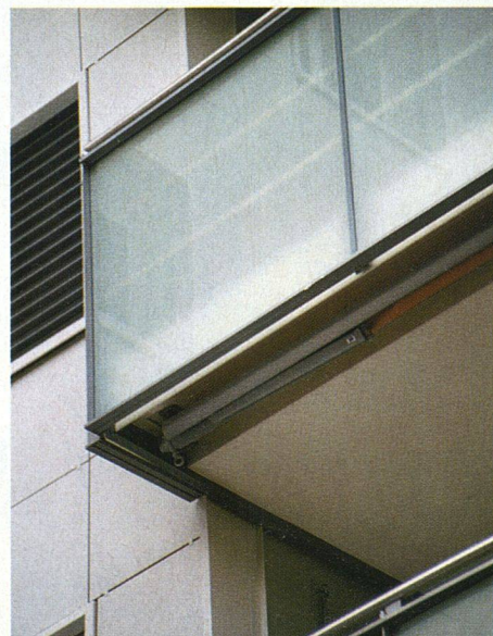
Die Verkleidung der vergrösserten Balkone im Detail
