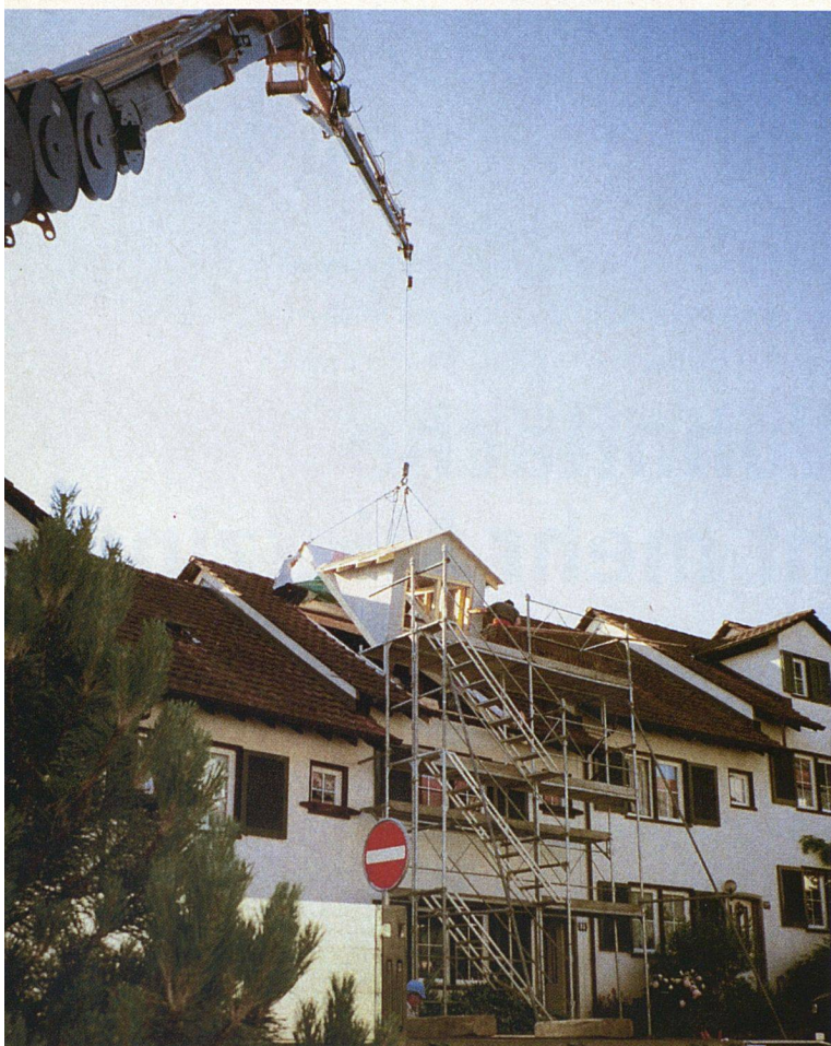
Kurze Bauzeit dank vorfabrizierter Teile: Die fertigen Lukarnen setzt der Kran zielgenau aufs Dach.
