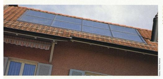
Die Solaranlage auf dem Dach der Liegenschaft Römerweg in Effretikon hilft beim Heizen und liefert Energie fürs Warmwasser.
