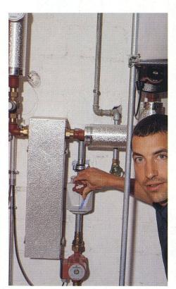
Installateur Stefan Gänsicke erklärt die Warmwasserproduktion. Dank dem speziellen Wärmetauscher entsteht kein Kalk und die Sonnenenergie wird optimal genutzt.
