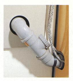
Sparen lässt sich auch beim Kamin. Da die Abgase nur noch 30 bis 50 Grad heiss sind, reicht ein dünnes Kunststoffrohr, um sie übers Dach abzuführen. Auch in Effretikon führt ein Kunststoffrohr die Abgase vom Kessel zum gemauerten Kamin.
