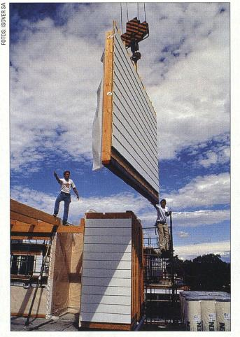
Bild oben: Fünf Geschosse hoch tragen die modernen Holzelemente. Bild links: Vorfabrikation und das niedrige Gewicht der Bauteile reduzierten die Bauzeit vor Ort.
