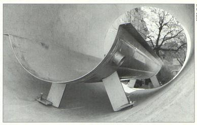
Voraussetzung für den effizienten Betrieb von Wärmepumpen ist eine Wärmequelle auf hohem Temperaturniveau. Im Bild das Modell eines Wärmetauschers, der Wärme aus Abwasser gewinnt.
