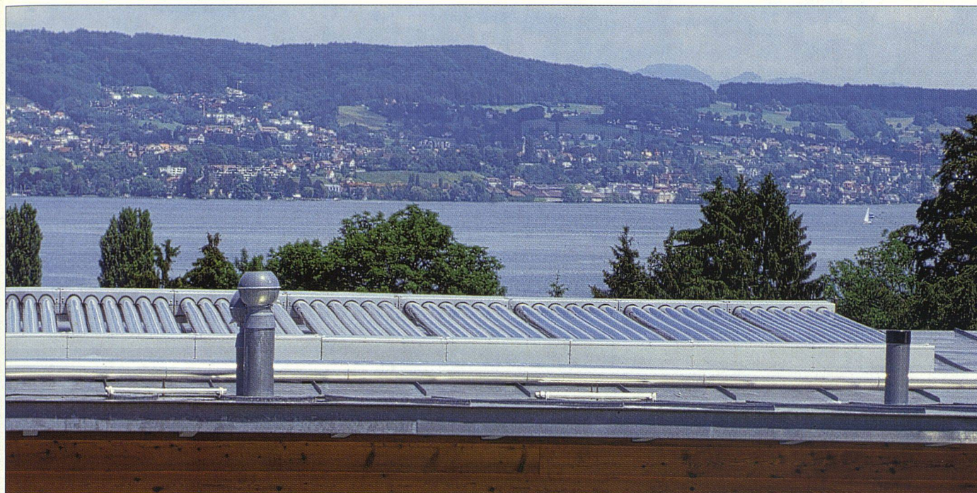
Sonnenkollektoren liefern in der Siedlung Cholenrain in Horgen einen Drittel des Warmwassers.
