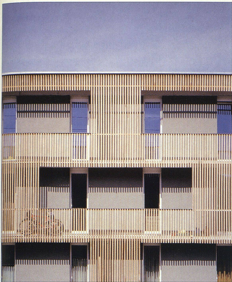
Der schleierartige Eichenholzrost nimmt der massiven Kontur die Härte und schafft einen hellen, aber gleichwohl geschützten Balkonraum.
