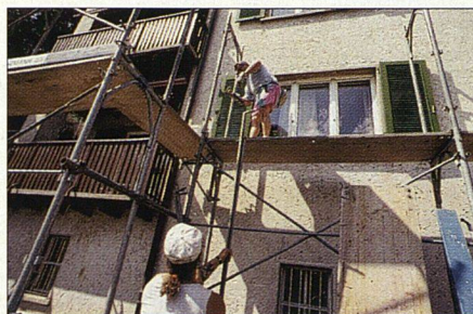
Nach den notwendigen Rodungen wird das Gerüst hochgezogen und anschliessend das Haus eingenetzt.
