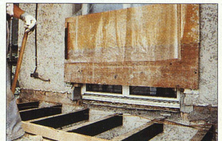
Die alten Balkone lagen auf hölzernen Trägern. An deren Stelle wird eine wesentlich grössere Betonplatte eingegossen.
