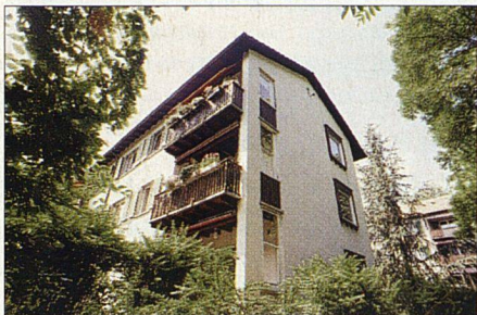
Das Haus vor der Erneuerung. Die Gebäudehülle ist 55 Jahre alt. Die Zustandsanalyse liegt bereits drei Jahre zurück.
