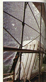
Die kommenden Monate werden für die Mieter/-innen viel Tütel und Türen werden getauscht.
