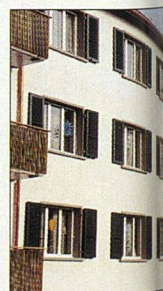
Die neue Fassade wurde in mehreren Etappen erstellt. Die Fenster wurden ersetzt, die Rolläden über den auf 10 m erhöhten
