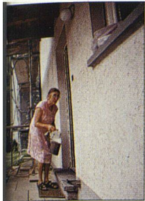
... verlangen von den ... anz. Die neuen Fenster ... zu Beginn eingesetzt.
