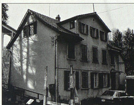
Sittertalstr. 21 in St. Gallen vor der Sanierung – ein Projekt von «Hausen und Wohnen».
