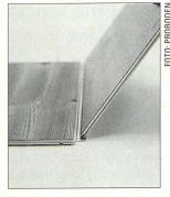
Eine speziell gefräste Nut-Kamm-Verbindung und eine befestigte Aluminiumschiene halten die einzelnen Paneele längs- wie auch stirnseitig zusammen.
