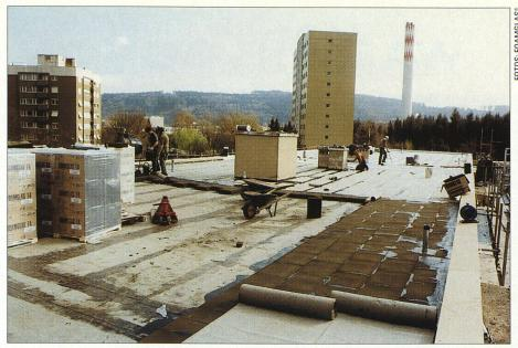
Auf 580 Quadratmetern Dachfläche wurden 2150 Platten verlegt und anschliessend mit Folien geschützt.
