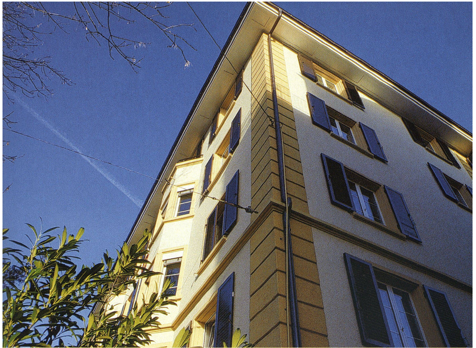
Allgemeine Baugenossenschaft Zürich, Schaffhauserstrasse, Milchbuck: 1993 wurden die 1923 erbauten Häuser innerlich und äusserlich saniert.
