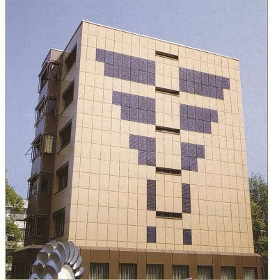
Das Kraftwerk in der Fassade als Gestaltungselement.
