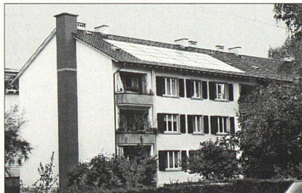
Solare Warmwasservorwärmung an der Rauracherstrasse 7-17 in Riehen
