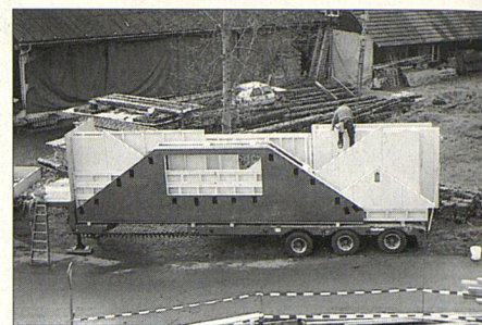
Die fixfertigen Elemente werden angeliefert...
