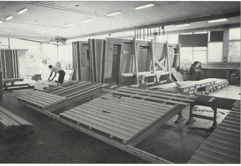
Wandelemente werden in der Montagehalle mit CAD vorgefertigt.
