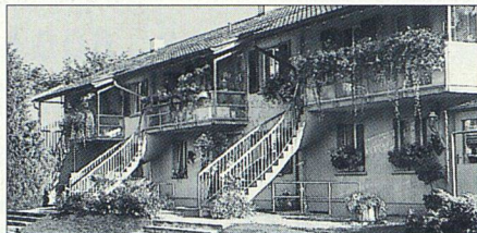
«Stägehüsl» mit sanierten und leicht vergrösserten Balkonen
