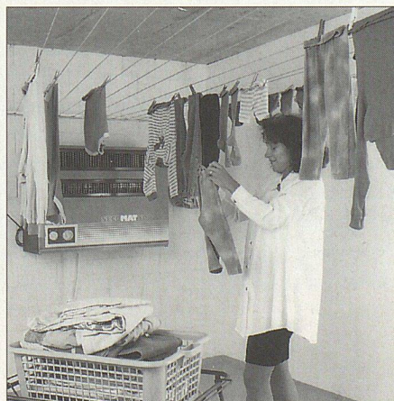
FOTO + ABBILDUNG: KRÜGER
