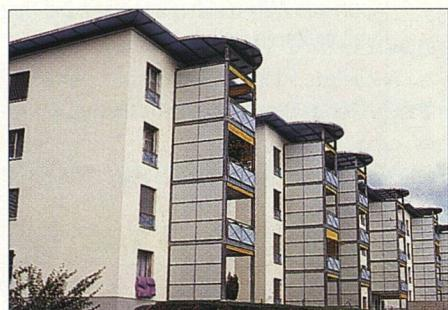
Eine geschickte Planung mit einfachen Fensterformen trägt zur Kostenreduktion im Fassadenbereich bei.
