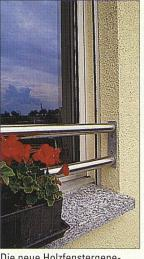
Die neue Holzfenstergeneration mit einem Flügel aus Holz/Metall: Der exponierte Fensterflügel ist vollkommen mit Metall abgedeckt, der Rahmenteil ist im Mauerwerk verankert.
