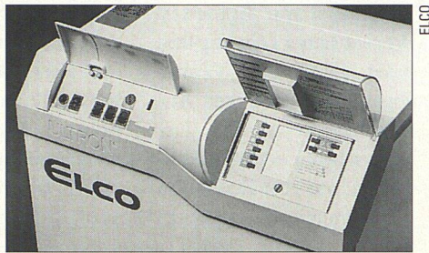
Der integrierte witterungsgeführte Digitalregler des neuen ULTRON.
