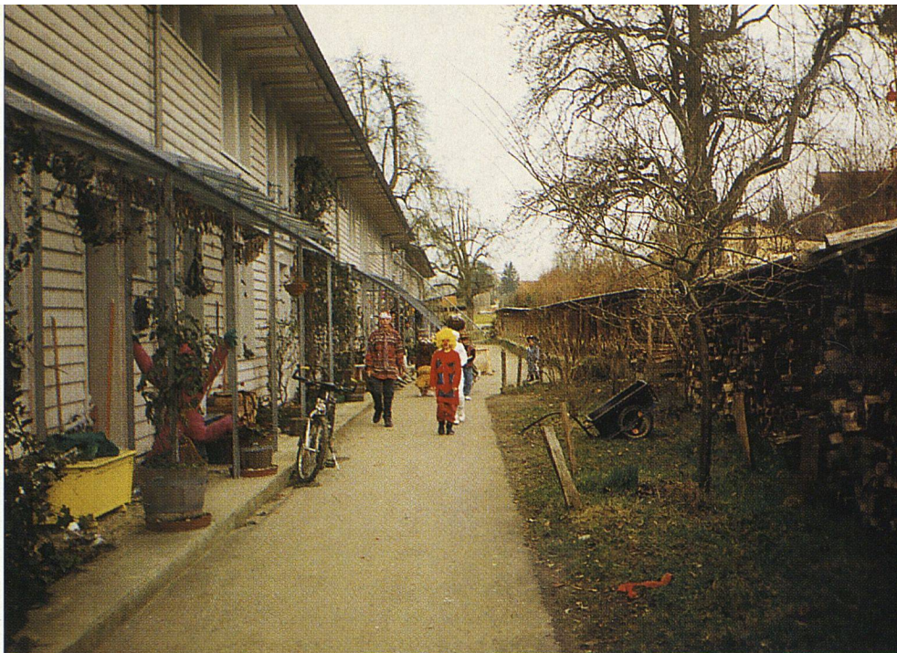
Vor jeder Heizsaison holen die Genossenschafter/innen vom «Öpfelbaum» in Stetten Holz aus dem Wald und schichten es miteinander zu ordentlichen Beigen.
