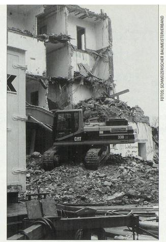
Abbruch mit der schweren Eisenkugel gibt's nicht mehr. Alles Brauchbare wurde vorher sorgfältig demontiert.
