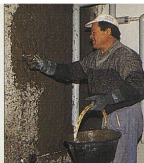
Drei Schichten Penetrat-Mörtel schützen Mauern vor Feuchtigkeit.
