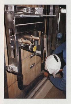
Geeignet für jeden Grundriss. Die Montageschienen wurden vom Sanitärinstallateur vor Ort den unterschiedlichen Raummassen und Einrichtungsvarianten angepasst.
