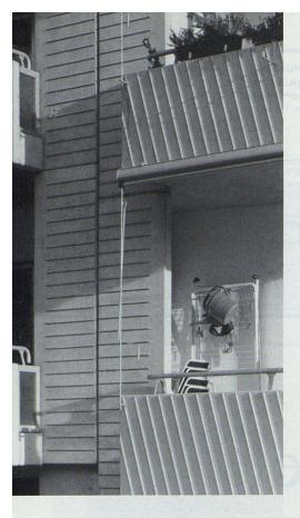
Die alten Balkonplatten wurden abgefräst und in ganzen Stücken mittels Pneukran
