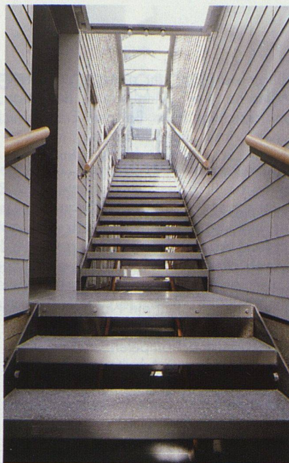
Die innere Erschliessung der Gebäude erfolgt über halbgesschossig versetzte Wohnungszugänge, die über ein Oberlicht natürlich belichtet sind.
