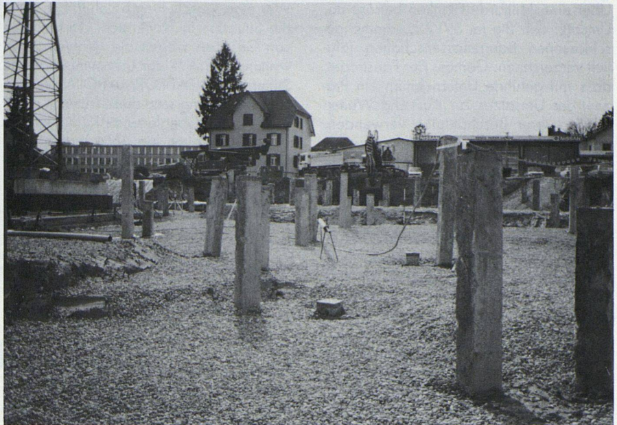
Eingerammte Fertig-Betonpfähle am Finkernweg, Kreuzlingen. Vor dem Anschliessen der Pfähle werden diese auf eine einheitliche Kote abgeschnitten..
