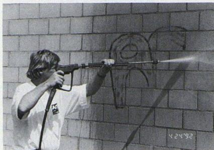
Ein Schutzfilm gewährleistet, dass Farbschmierereien mit einem Wasserdruckreiniger entfernt werden können.
