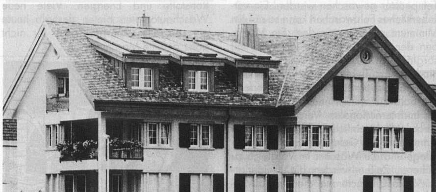
Warmwasser aus 20 m 2 Sonnenkollektoren. Ein sinnvoller Beitrag zur Reduktion des Schadstoffausstosses der Heizungen.
