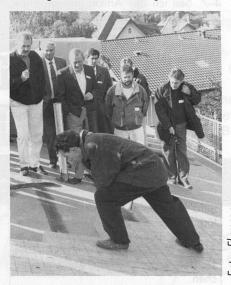
Demonstration der neuen, vollflächigen Verlegungsart von Dämmplatten am Steildach
