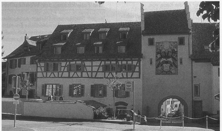
Oberhof in Stein am Rhein. Nach der Sanierung können auch Behinderte in diesem mittelalterlichen Gebäude wohnen. 13 der 14 Wohnungen und die Ladenräume im Erdgeschoss sind rollstuhlgängig.
