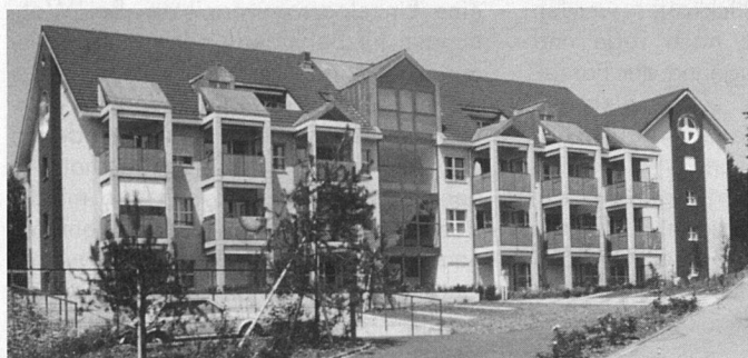
Kantonale Unterstützung half mit beim Bau der Siedlung «Sonental» in Uster.
