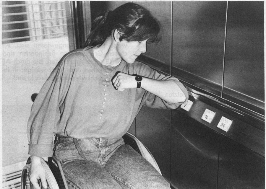
Speziell grosse Tasten ermöglichen Armbehinderten, das Fahrziel mit dem Ellenbogen zu wählen.
